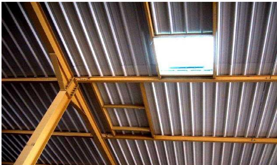
Exemple d'une toiture en Bac acier (T.A.N) d'un centre commercial
